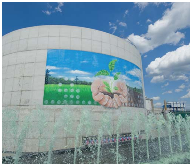
Vergistinginstallatie van Attero in Venlo
