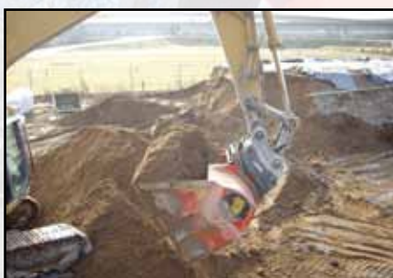
Stabiliseren van fundering lagen
