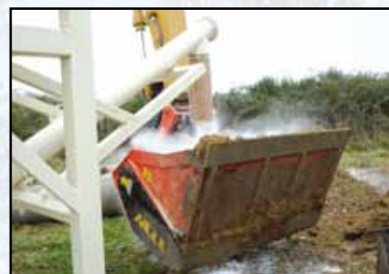
Stabiliseren klei / leem met kalk
